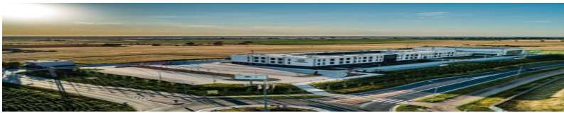
Budowa Zespołu Szkół Technicznych w Tarnowie Podgórnym
