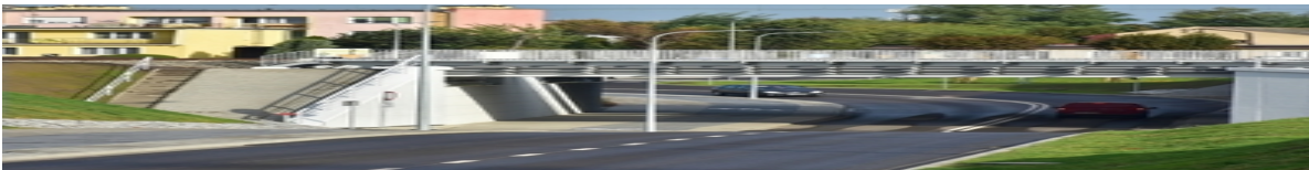
Rozbudowa układu drogowego ul. Pod Trzema Mostami w Gnieźnie, na odcinku od al. Reymonta do ul. Osiniec.
