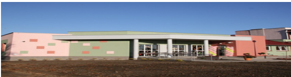
Budowa Przedszkola w Starych Oborzyskach
