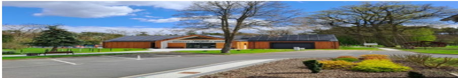
Budowa „Centrum Edukacji i Promocji Drewna” wraz z wyposażeniem.
