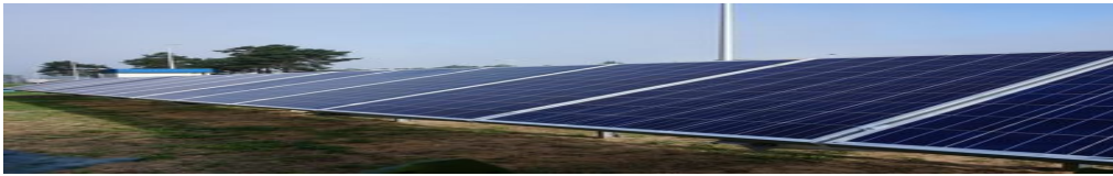
Budowa Centrum Badawczo-Rozwojowego OZE przez GWDA sp. z o.o. w Pile
